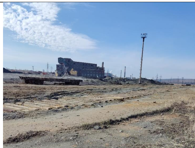
Демонтированный ж/д путь к югу от отделения сушки
