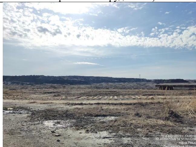
Спланированная поверхность в северной части участка рекультивации, демонтированный ж/д путь
