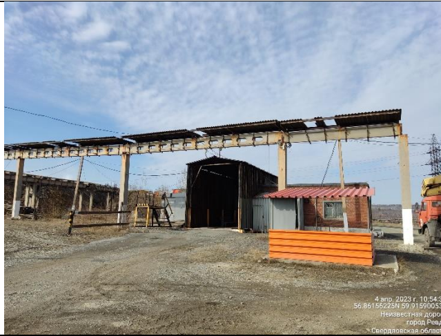
Весовая, эстакада поверхностных коммуникаций
