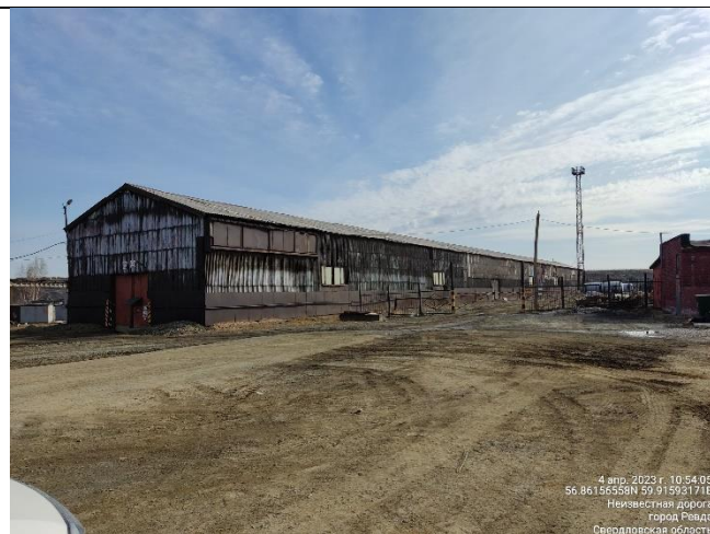
Спланированная поверхность в центральной части участка рекультивации (склад крупногабаритного оборудования)
