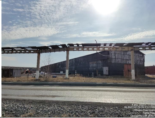
Здание склада крупногабаритного оборудования
