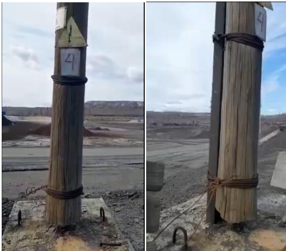
Рисунок 5.1 – Конструкция переносных опор ЛЭП
